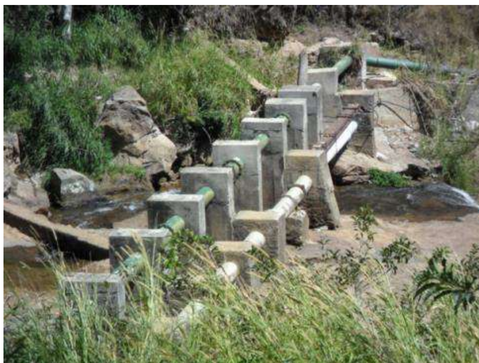
Figura 37 - Adutoras da Ponte de Ferro e Caxambu Pequeno em paralelo, diâmetro de 300mm
