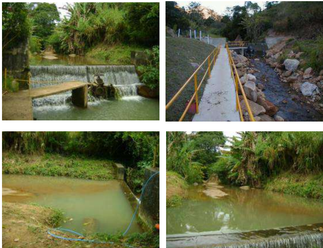
Figura 63 - Captação e Adutora de Água Bruta TAQUARIL
